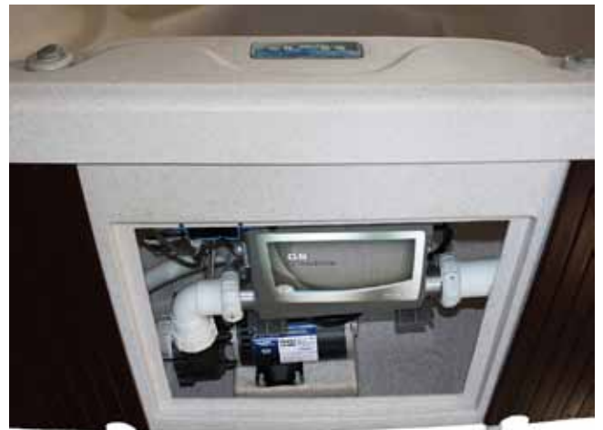
Der Zugang zum Maschinenaggregat befindet sich unter dem obenliegenden Bedienfeld.
