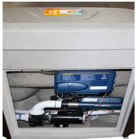
Der Zugang zum Maschinenaggregat befindet sich unter dem obenliegenden Bedienfeld.
