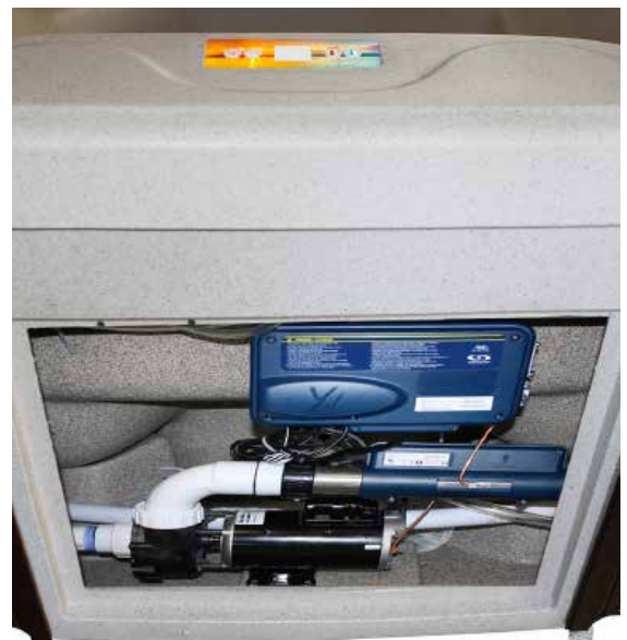
Der Zugang zum Maschinenaggregat befindet sich bei den meisten Whirlpools unter dem obenliegenden Bedienfeld.
