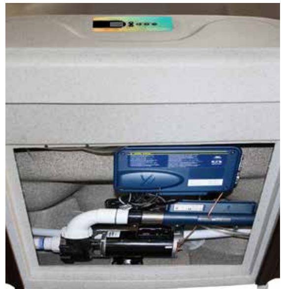
Der Zugang zum Maschinenaggregat befindet sich bei den meisten Whirlpools unter dem obenliegenden Bedienfeld.
