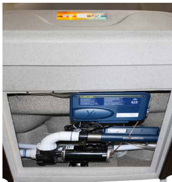
De toegang tot de apparatuur bevindt zich bij de meeste spa's onder het controlepaneel op de bovenkant van de spa.
